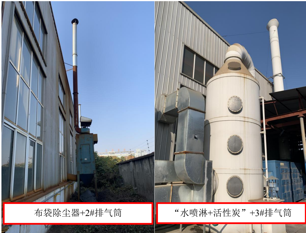
废气处理设施及排气筒图片
