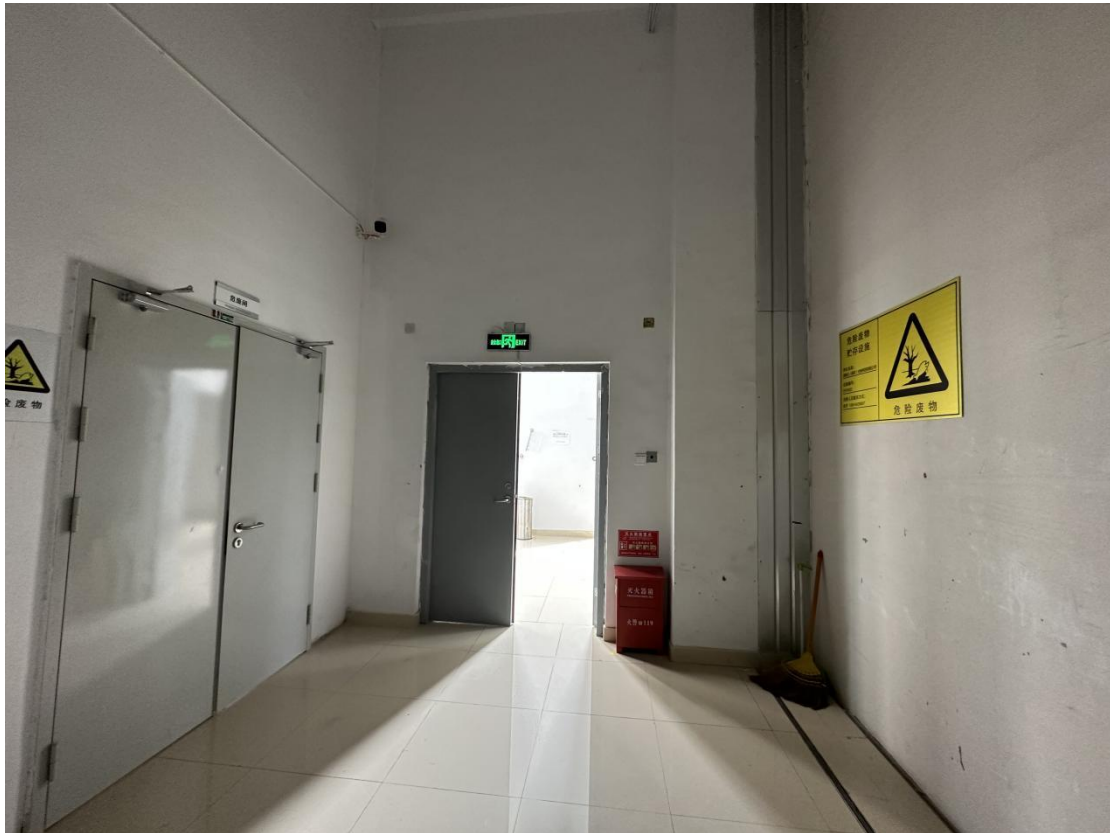
危险废物贮存设施
